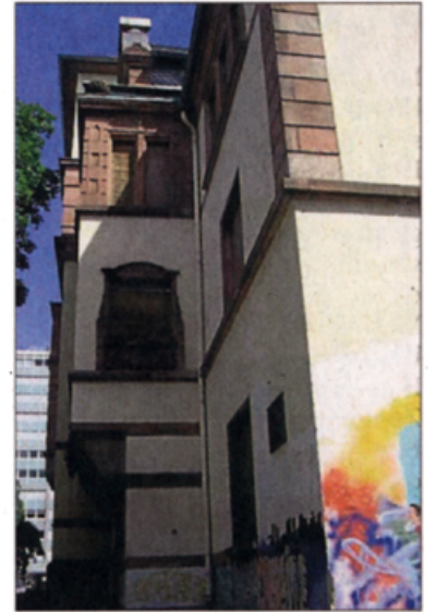
Nach dem Umbau des ehemaligen JUZ soll die Schulverwaltung einziehen. Foto: Archiv
