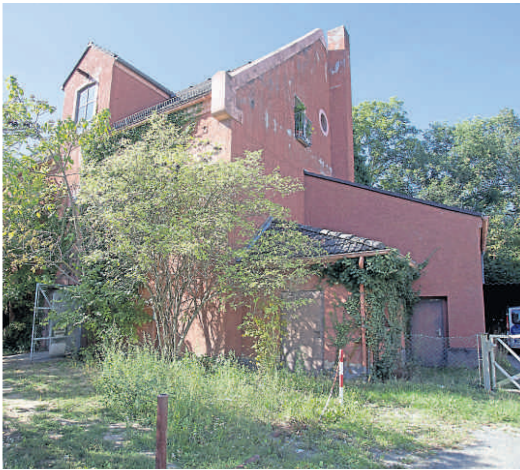
Der bis heute erhaltene Hochbunker in der Goldsteinstraße 302.
